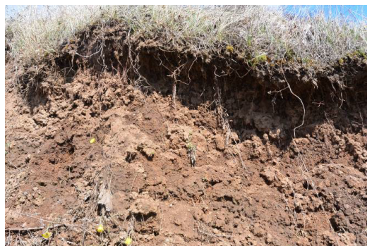
Фото 10. Стенка срыва оползня
