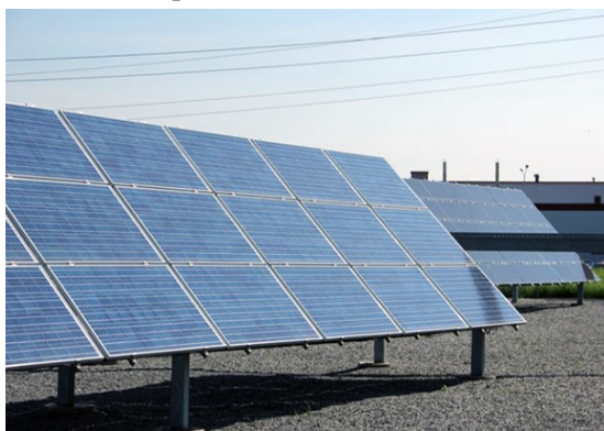
Фото 2. Солнечная электростанция в Белгородской области
