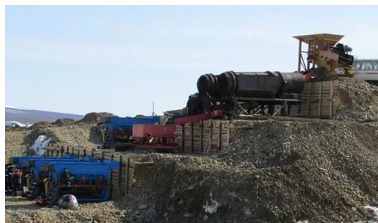
Рис. 3. Монтаж промывочного прибора с отсадочной технологией обогащения
