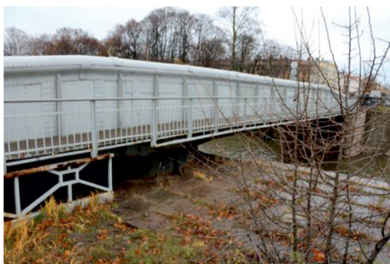
Рис. 6. Разводной мост. Уникален тем, что его металлическая конструкция отводится в сторону в специально подготовленную нишу
