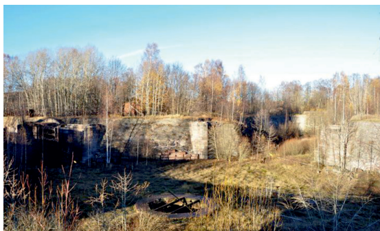
Рис. 8. Крестовина сухого дока, куда заходились большие и малые суда. С правой стороны небольшой наклон (38°), чтобы вода самотеком уходила через овраг в бассейн. Док осушался за несколько часов и был доступным для ремонта кораблей. Аналогов такого сооружения Европа еще не знала
