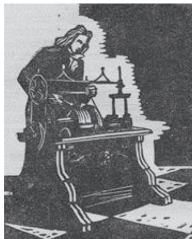
Рис. 17. Гравюра, изображающая токарный станок, изобретенный А.К. Нартовым. Впервые задействован на строительстве дока в Кронштадте
