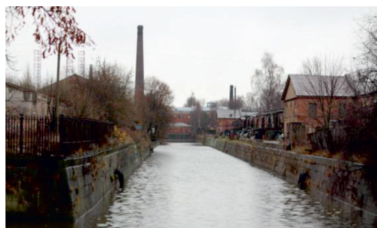
Рис. 24. Ветвь канала, проходящая вдоль цехов Морского завода
