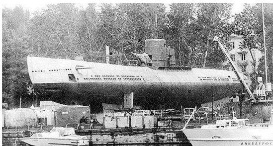
11. «Д-2» на берегу. Идут последние работы по превращению корабля в музей
